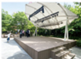
바닥 확장 공사 완료
