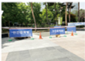
광장 바닥 물고임 현상 방지 공사
